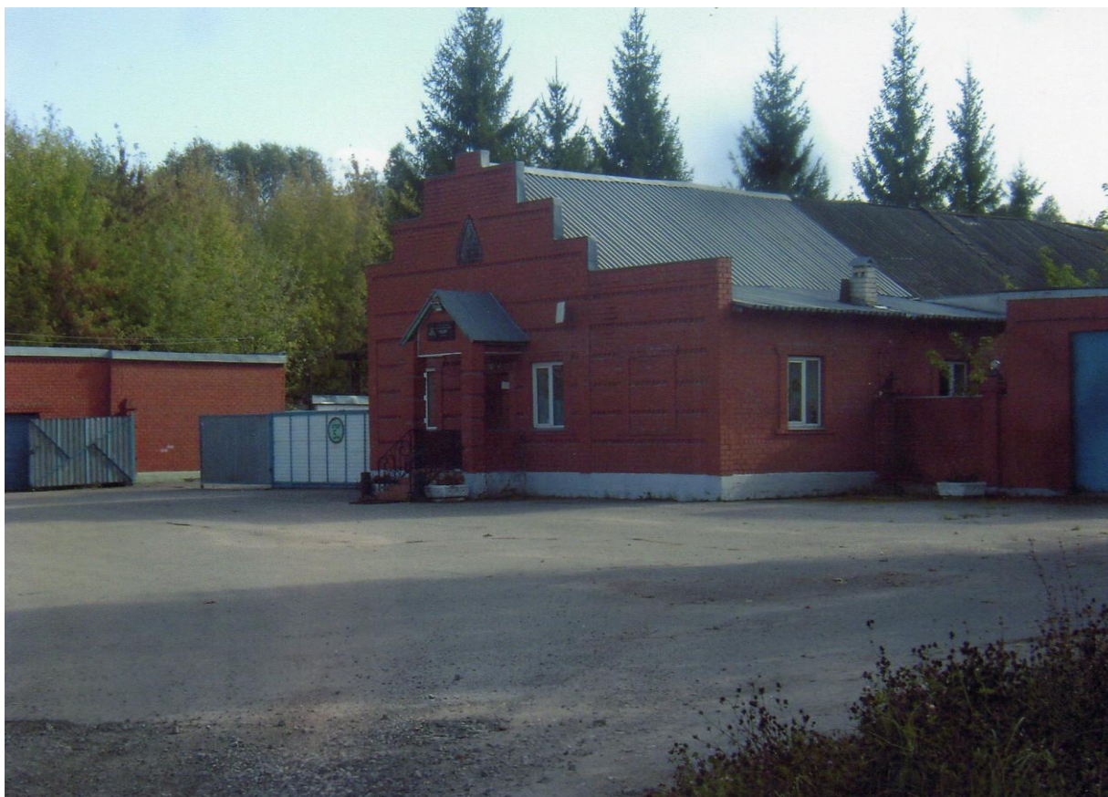
Проходная завода и обновленное здание конторы
